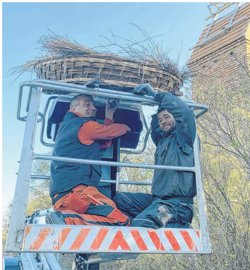
Enrico Kulow (l.) und René Hinrich setzten gestern kurz nach 8 Uhr das neue Storchennest auf den Transformator.
